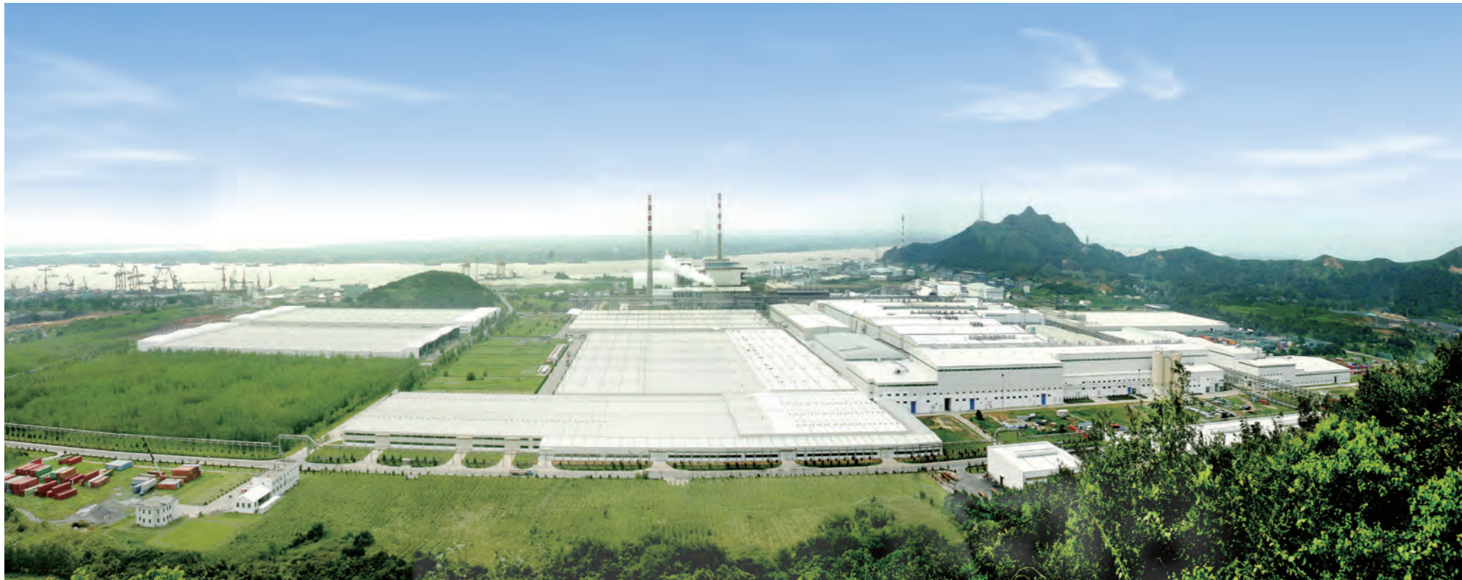
APP (中国) 旗下金东纸业厂房顶部光伏能源利用项目
